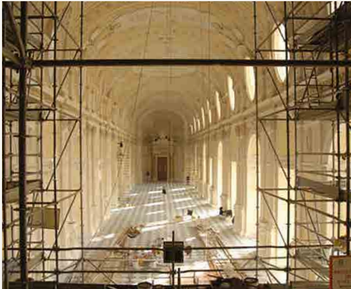
Restauro della Reggia di Venaria Reale durante i lavori (terminati nel 2007)
